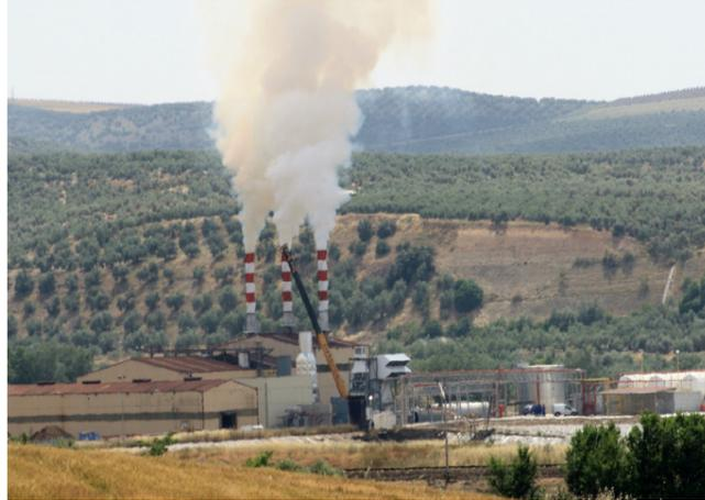
**Proyecto de Instalación de Planta de Cogeneración de 13 MW con turbina de gas en planta de secado de orujo de dos fases, en Jabalquinto (Jaén).**
